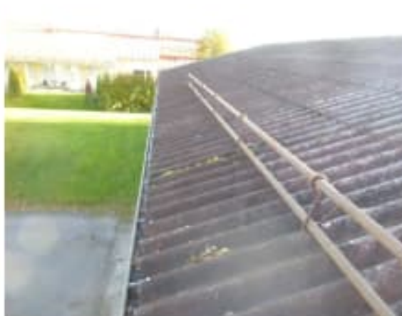
Kuva 116 Yleiskuva pohjoisen puoleiselta lappeelta.
