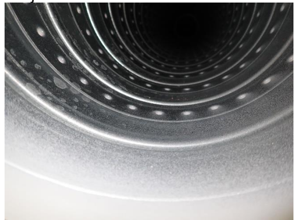
Kuva 171 Tuloilman suutinkanavan sisäpintaa luokassa. Ei havaittavaa pölyä.
