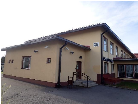
Kuva 52 Rakennuksen pohjoispuolen julkisivu.
