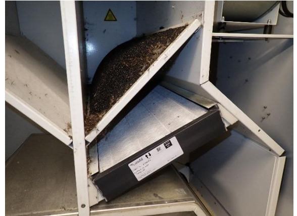
Kuva 153 Tuloilman suodattimet ovat tasosuodattimia.
