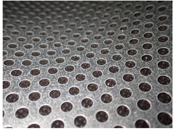
Kuva 169 Kanaviston äänenvaimentimien pinta suojattu.
