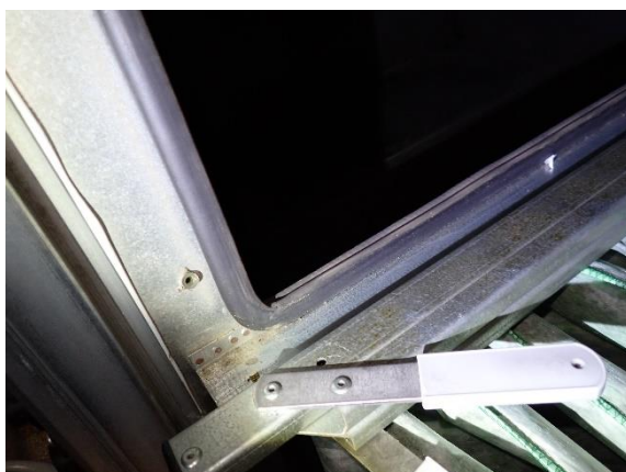
Kuva 132 TK1/PK1 suodattimien kiinnitys on tiivis.
