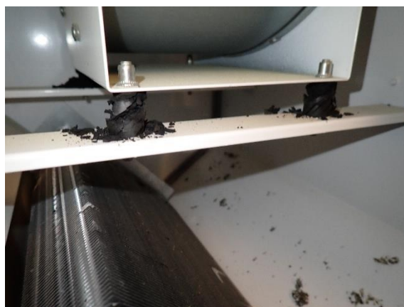
Kuva 157 TK5/PK5 puhaltimien vaimenninkumit ovat murtuneet.
