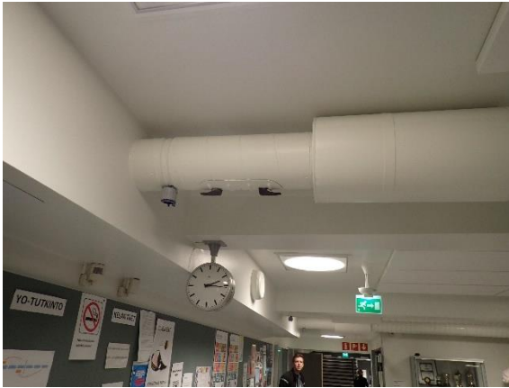
Kuva 168 Kanavaäänenvaimennin aulatilassa
