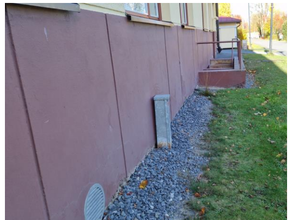
Kuva 9 Sokkelin vierustalle on laitettu sorastus (50-luvun osa).
