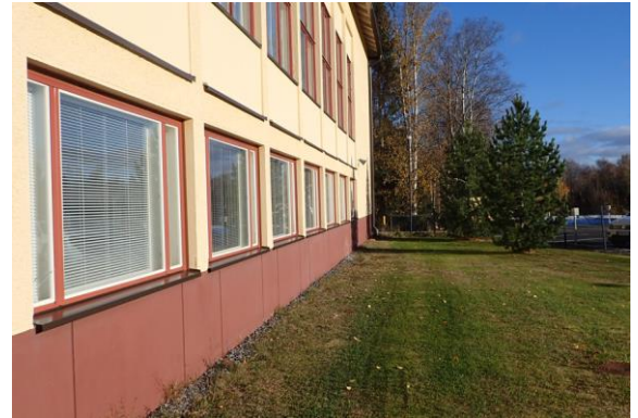
Kuva 7 Rakennuksen takapiha on nurmikkopintaista. Maa viettää poispäin rakennuksesta vain vähän.
