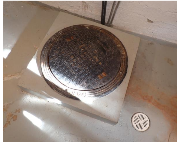
Kuva 38 Lämmönjakotilassa on pohjavesipumppu / harmaiden vesien pumppu, josta voi mahdollisesti aiheutua liiallista pohjavedenpinnan tason laskua, jos puupaalujen yläosat jäävät pohjavesipinnan yläpuolelle.
