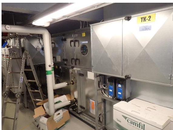
Kuva 138 Ilmanvaihtokone TK-2.
