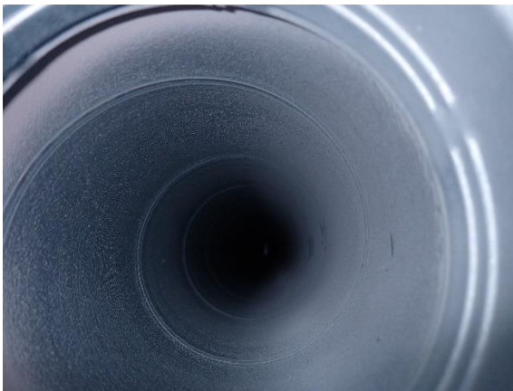
Kuva 170 Poistoilmakanavassa tavanomaista pölylyyntymistä.
