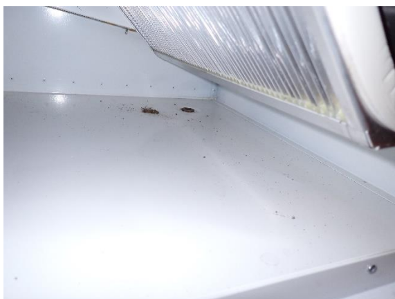
Kuva 160 TK6/PK6 on sisäosiltaan puhdas.
