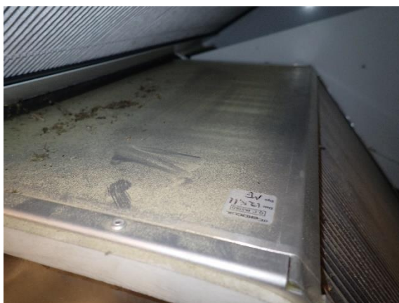
Kuva 154 Koneen sisäosissa runsaasti siitepölyä.
