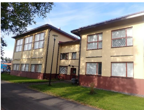
Kuva 54 Rakennuksen idän puoleista julkisivua.
