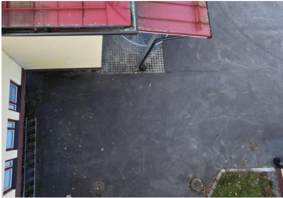
Kuva 6 Sisäpihan alue on asfalttipintaista aluetta. Valumavedet on ohjattu sadevesikaivoihin.
