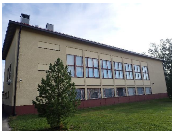
Kuva 53 Rakennuksen etelän puoleinen julkisivu.
