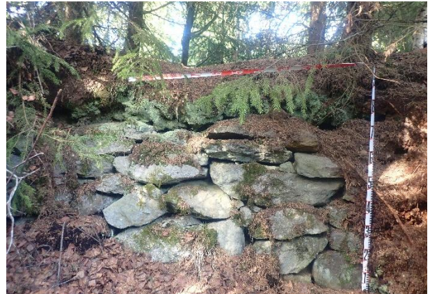
Kuva 22. Maakellari 2:n pohjoinen kivirakenne. Pohjoiseen.
