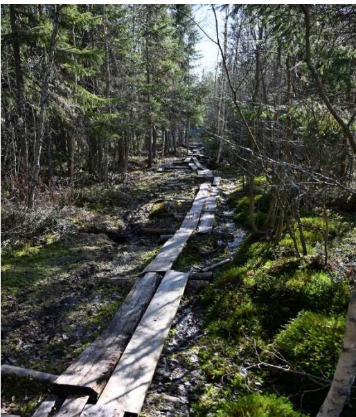
Huonokuntoiset pitkospuut korven eteläpäässä.
