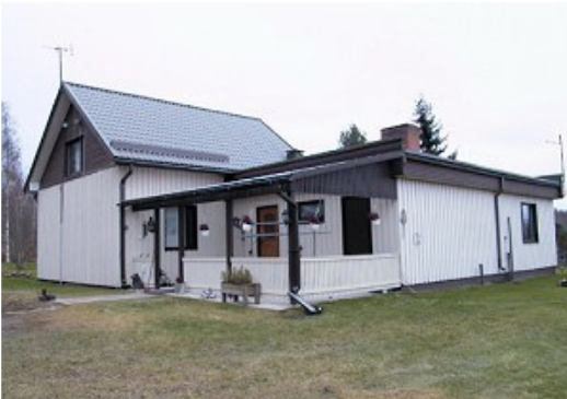
Asuinrakennus kuvattuna pohjoisesta. Kuvaaja: Tiina Lehtisaari. Kuvausaika: marraskuu 2004
