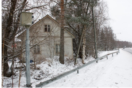
Yllä oikealla: Erkkilän vanha asuinrakennus Seinäjoentieltä pohjoisen suunnasta kuvattuna. Kuvaaja: Kerttu Loukusa. Kuvausaika: 23.4.2024
