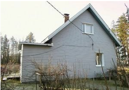
Asuinrakennus pohjoispäädystä. Kuvaaja: Tiina Lehtisaari. Kuvausaika: marraskuu 2004
