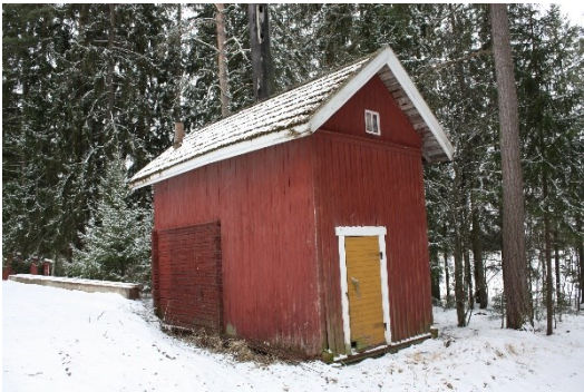
Viljankuivaaja on pihapiirin vanhimpia rakennuksia, joka on siirretty paikoilleen 1914. Kuvaaja: Kerttu Loukusa. Kuvausaika: 23.4.2024
