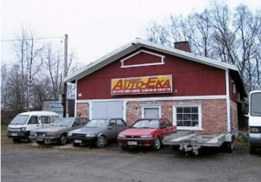
Entisen navetan pohjoispääty. Rakennus on varastokäytössä. Kuvaaja: Tiina Lehtisaari. Kuvausaika: marraskuu 2004
