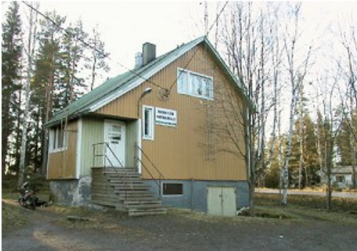
Nuorisotalo Pokela kuvattuna koillisesta. Taustalla kantatie 67. Kuvaaja: Tiina Lehtisaari. Kuvausaika: marraskuu 2004
