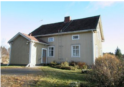
Oikealla: Asuinrakennus kuvattuna lännestä. Kuvaaja: Tiina Lehtisaari. Kuvausaika: lokakuu 2004
