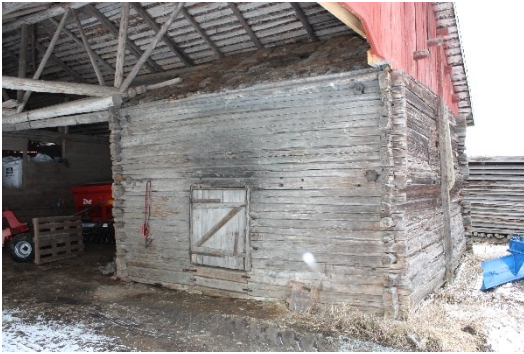
Yllä: Riihi lännestä kuvattuna. Rakennus sijaitsee ladon katoksen alla. Kuvaaja: Kerttu Loukusa. Kuvausaika: 23.4.2024
