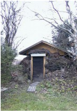
Maakellari sijaitsee pihan länsi reunalla. Kuvaaja: Tiina Lehtisaari. Kuvausaika: lokakuu 2004
