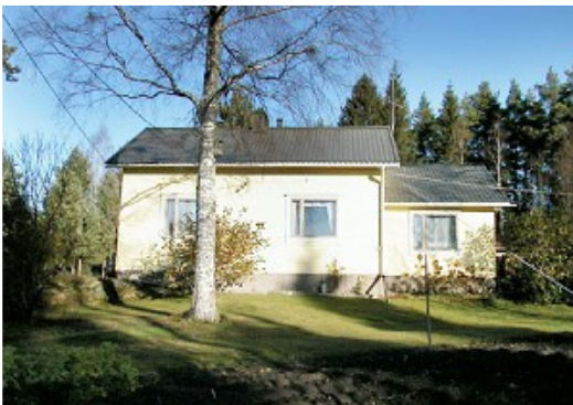
Julkisivu etelään. Kuvaaja: Tiina Lehtisaari. Kuvausaika: lokakuu 2004
