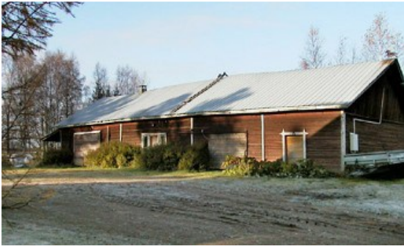
Vasemmalla: Ulkorakennus. Kuvaaja: Tiina Lehtisaari. Kuvausaika: lokakuu 2004
