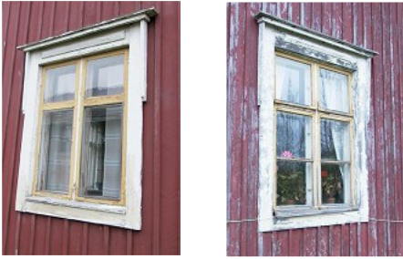
Yllä vasemmalla: Länsipäädyn ikkuna alkuperäinen. Kuvaaja: Tiina Lehtisaari. Kuvausaika: lokakuu 2004
