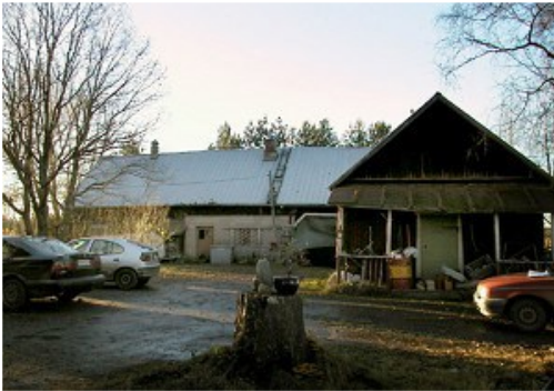
Ulkorakennus kuvattuna idästä. Kuvaaja: Tiina Lehtisaari. Kuvausaika: lokakuu 2004
