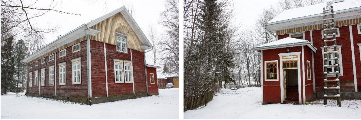
Yllä: Asuinrakennuksen pohjoispääty ja itäjulkisivu. Kuvaaja: Kerttu Loukusa. Kuvausaika: 23.4.2024
