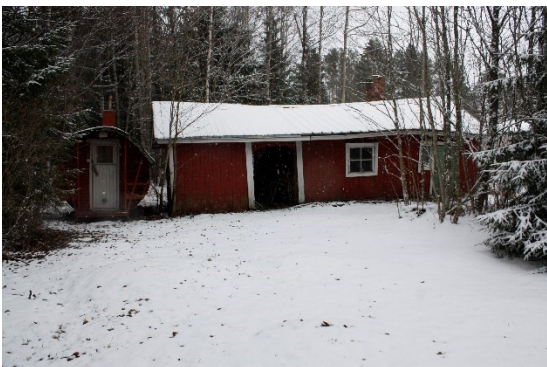
Yllä oikealla: Julkisivu luoteeseen. Kuvaaja: Kerttu Loukusa. Kuvausaika: 23.4.2024
