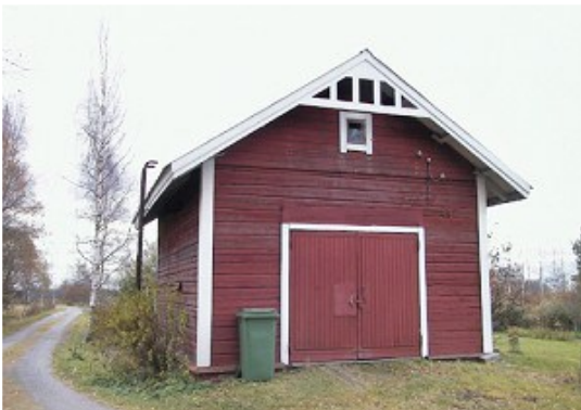
Pohjoispääty. Sauna on muutettu autotalliksi 1970-luvulla. Kuvaaja: Tiina Lehtisaari. Kuvausaika: lokakuu 2004
