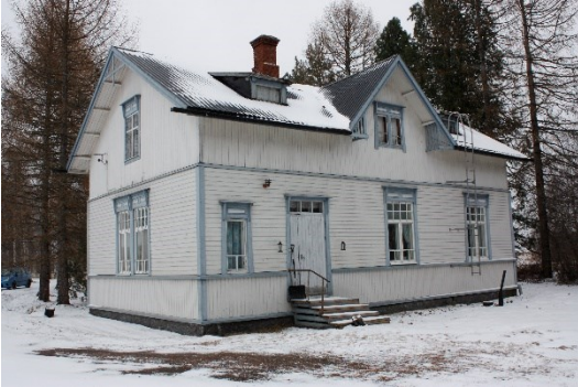
Asuinrakennus sisäpihalta lännestä. Kuvaaja: Kerttu Loukusa. Kuvausaika: 23.4.2024
