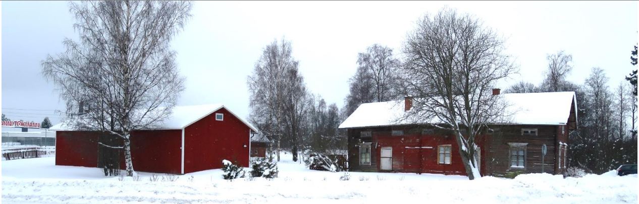
Ulkorakennus ja vanha asuinrakennus Palontieltä.
