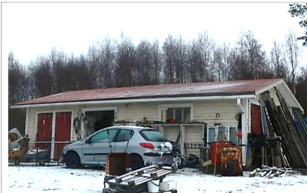
Ulkorakennus luoteesta pihan puolelta
