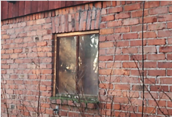
Navetan ikkuna ja tiilimuurausta.
