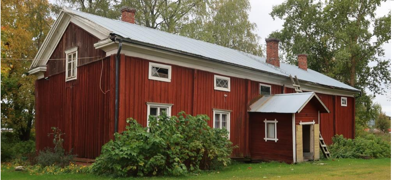
Pihan puolen julkisivu.
