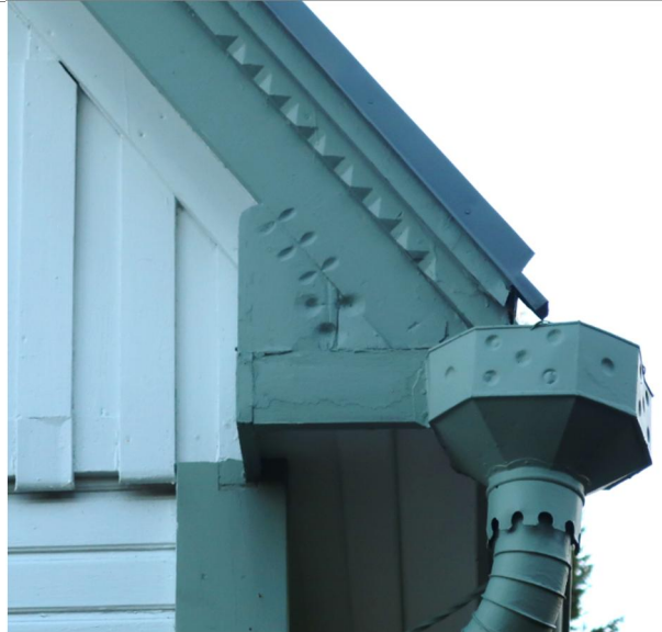
Syöksytorven pää ja vuorilaudoituksen koristeaiheita.
