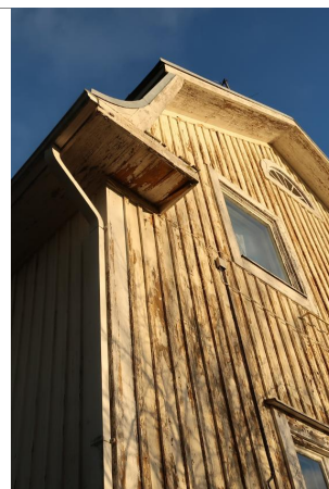
Syöksytorvi ja räystäään yksityiskohta.
