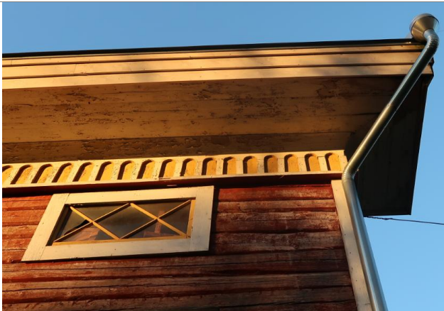
Raystäs ja yläkerran ikkuna.
