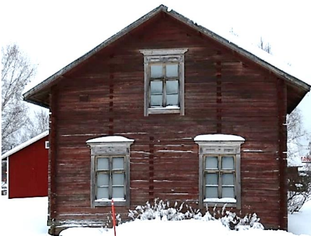
Pääty Aamukujan suuntaan (luoteeseen).
